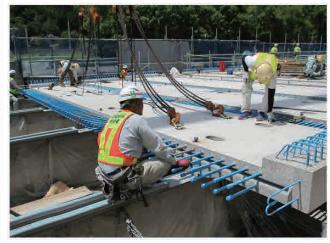
損傷したRC床版(鉄筋コンクリート床版)をより耐久性の高いPC床版(プレストレスコンクリート床版)に取り替えるんだ
