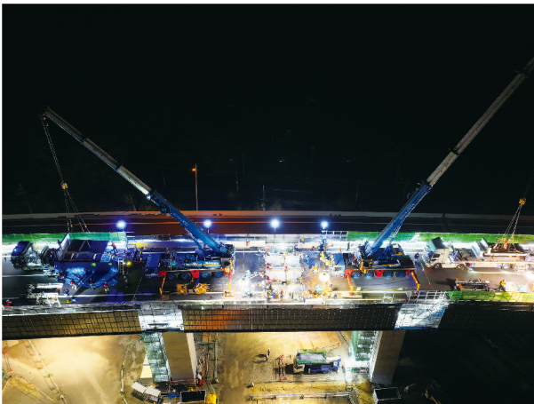
床版取替状況(境谷橋)
