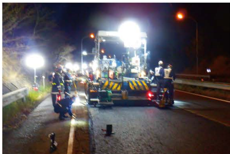
舗装補修工事(イメージ)
