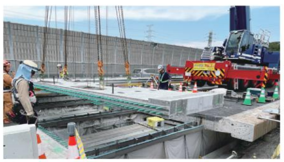
宝塚IC～神戸JCTの工事実施状況
